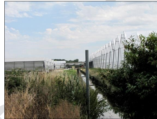
Emprise du site horticole sur la rivière : un enjeu d'avenir pour l'établissement et plus largement pour la commune
